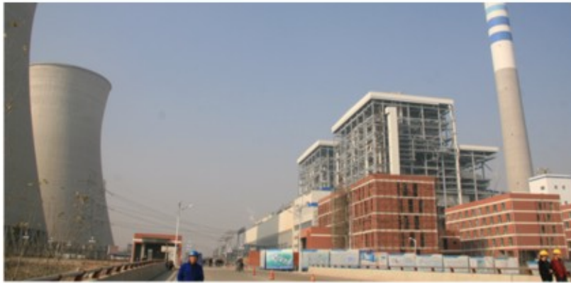
由东方锅炉提供锅炉设备和脱硝EPC项目——平顶山2×1000MW机组工程
