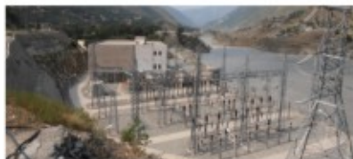
汉瓦水电工程3台机组全部初步移交
