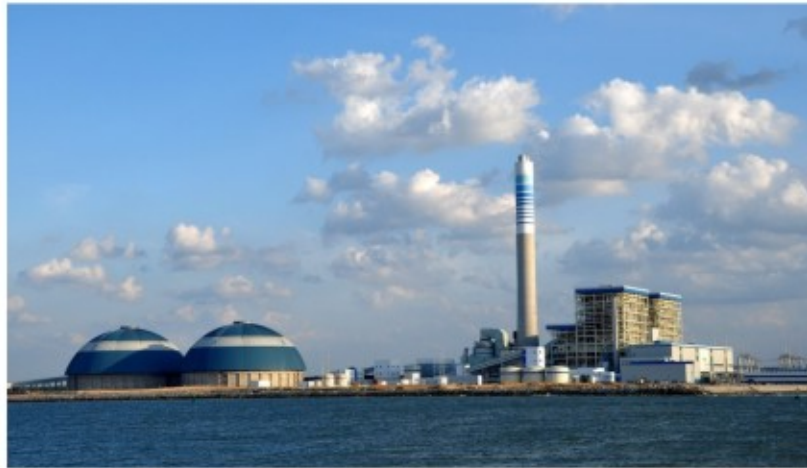
2012年11月4日19时38分，随着168小时满负荷试运行的完成，由东方电气提供三大主机设备的中国首座智能化生态电厂（莱州电厂一期工程2×1000MW超超临界机组项目）正式投产发电。
